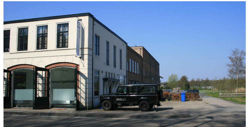
Voormalige bollenschuur en rijksmonument aan Herenweg
